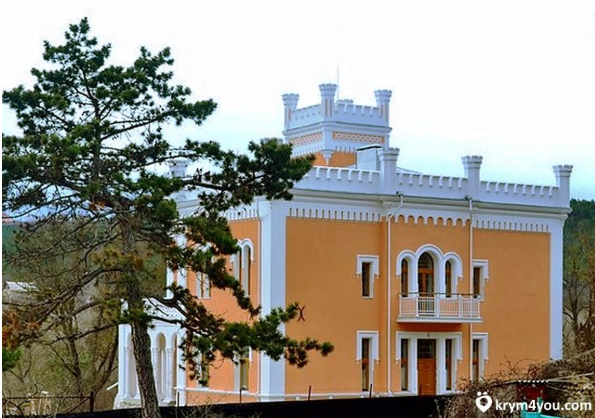
Рисунок Г.2 - Вид здания в наше время
